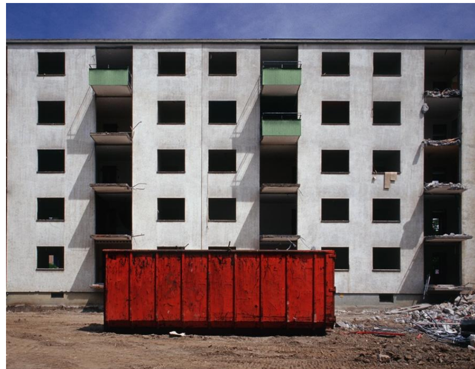
Umsicht beim Rückbau, Recyclingquote 90%
