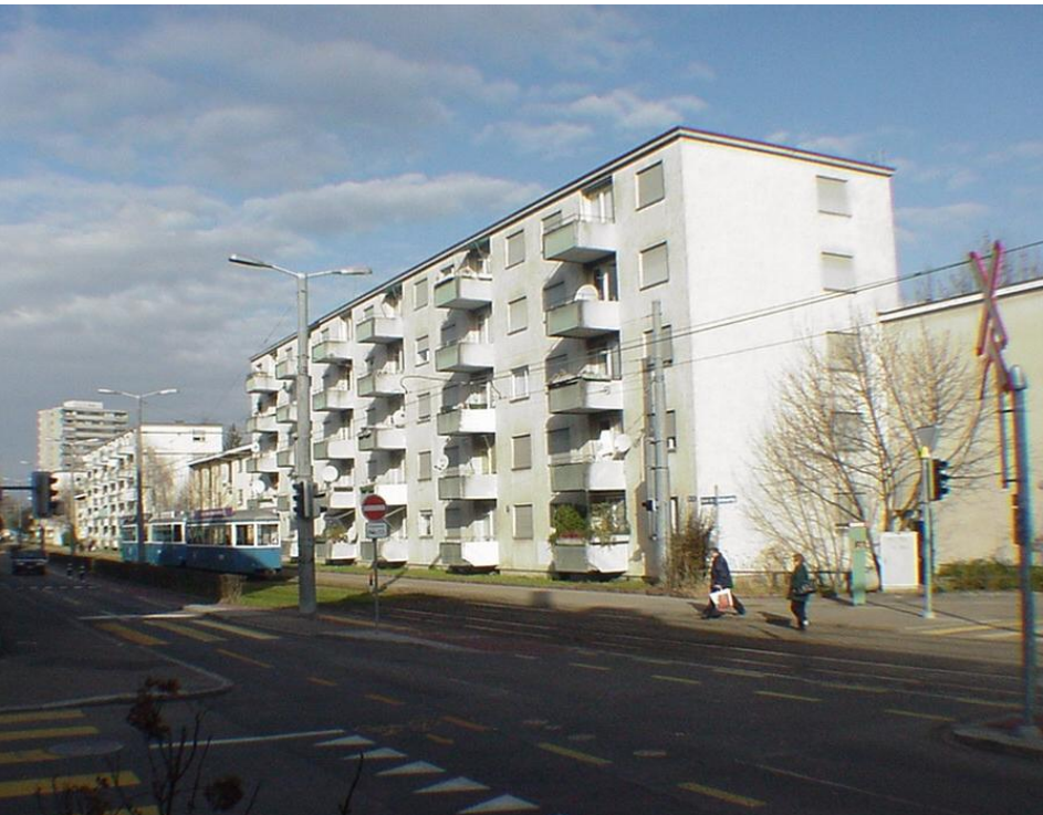
Siedlung Werdwies vor der Sanierung
