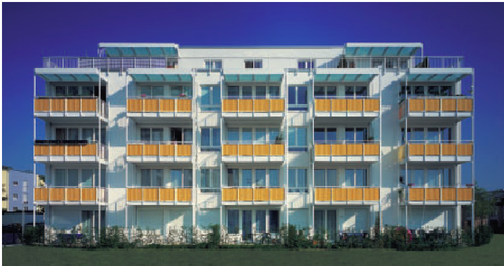
Abbildung 5: Niedrigenergiehaus Felicitas-Füss-Straße 15, München; Reine Baukosten: 1.180,- Euro/m 2
