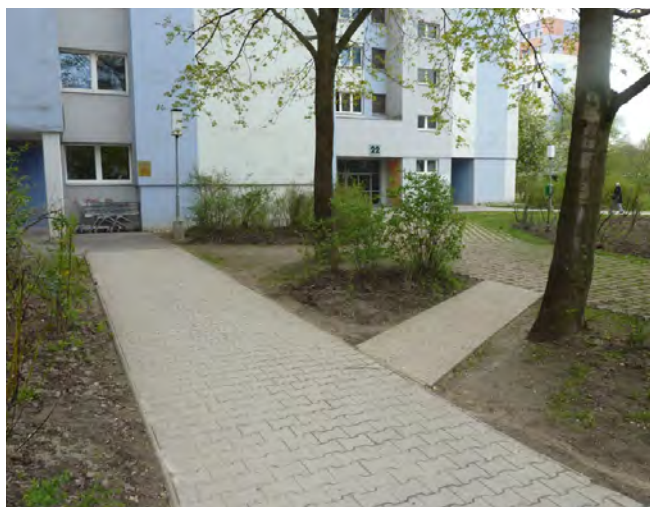
1210 Wien, Mitterhofergasse 2-18, Dr. Franz Koch-Hof: Das offenbar mangelhafte Wegesystem erfordert ein oftmaliges Nachbessern und das Befestigen der Trampelpfade. Das führt zu einer funktional und gestalterisch unbefriedigenden Situation.
