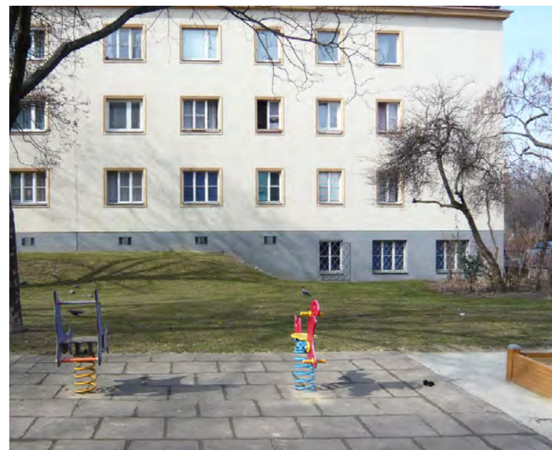
Standardausstattung: Eine Sandkiste und zwei Wipptiere für eine Anlage mit 273 Wohneinheiten. Räumlich ist der Kinderspielplatz nicht in den Hof integriert.
