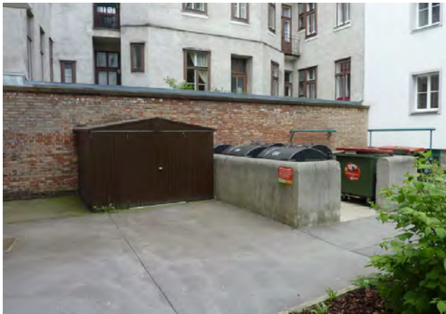
Zuordnung des Geräteschuppens zu den Müllgefäßen. Geräteschuppen haben Einzug in nahezu jeden Freiraum der Gemeindewohnbauten gehalten, jedoch ohne Anspruch an Gestaltung und räumliche Positionierung.
