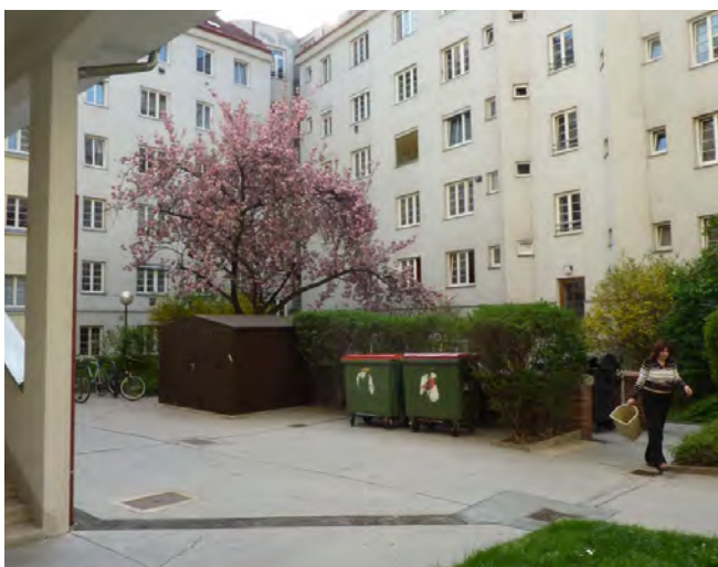
1030 Wien, Dietrichgasse 20 (erbaut 1926-27): Der zentrale Bereich des Hofes ist von Mülltonnen und einer Gerätehütte besetzt - sowohl optisch als auch hinsichtlich der Nutzungsmöglichkeiten eine Verschlechterung.
