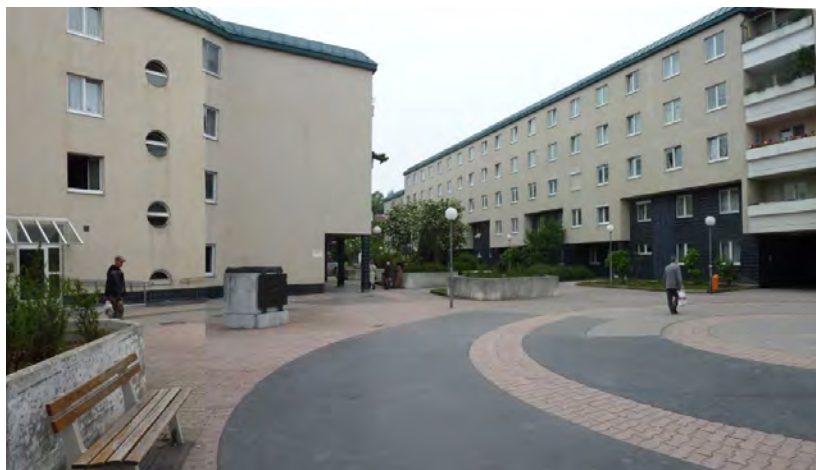
Der zentrale Platz der Anlage hat aufgrund seiner Gestaltung wenig Identifikationsfunktion und wirkt meist verlassen. Es gibt drei vereinzelt aufgestellte Sitzbänke. Die Materialwahl und der Zustand der Materialien hinterlassen einen etwas verwahrlosten Eindruck
