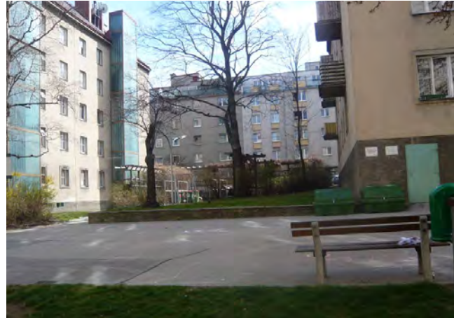
Offene Freiräume zur Straße zwischen Zeilenbauten könnten geschlossen werden, sodass ein geschützter Freiraum entstehen kann.
