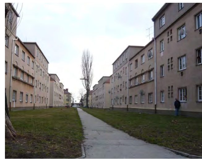
1100 Wien, Neilreichgasse 100-106, Johann Mithlinger-Siedlung (erbaut 1929-31): Der zentrale, schmale Weg führt durch einen völlig ausgeräumten Freiraum.
