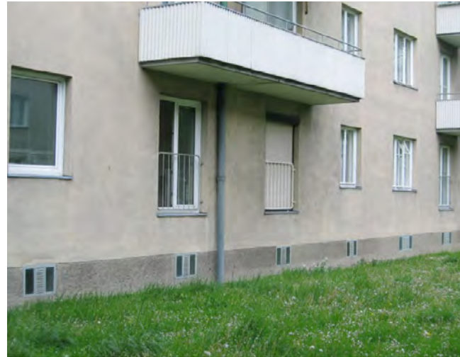
1210 Wien, Ödenburger Straße 73-85: Balkone und französische Fenster ohne Ausgang zu den Freiflächen schafft Abstandsgrün
