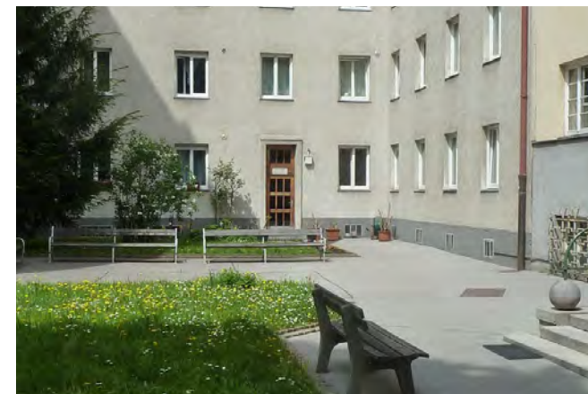
Hofseite Richtung Lasallestraße. Der angrenzende Gemeindebau wird auch über den gemeinsamen Hof erschlossen. In diesem Hofteil ist die Beschattung viel geringer, die Bänke sind besonnt und es findet Aneignung statt (Töpfe bei Hinterausgang, Rosen etc.)
