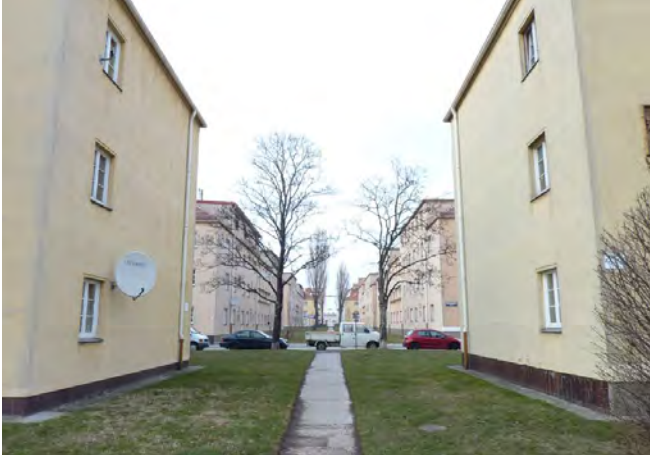
Freiraum ohne Ausstattung und Strukturierung, daher auch kaum nutzbar.
