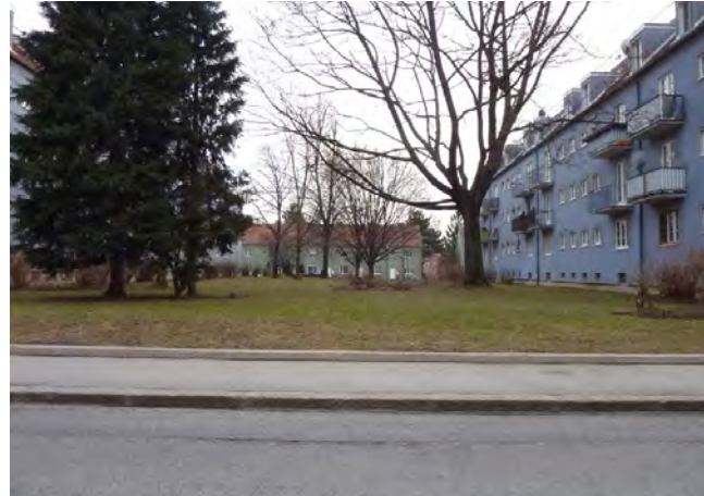
Hier fehlt eine Zuordnung der Freiräume zu den einzelnen Zeilenbauten. Eine Schließung des Freiraums zum Straßenraum mittels einer Hecke würde die Identifikation und Aneignungsmöglichkeiten verbessern.
