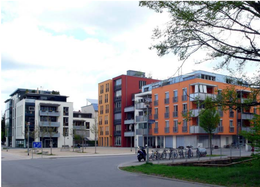
Platz des unbekannt-ten Deserteurs im Französischen Viertel in Tübingen, gesäumt von drei Baugemeinschaftshäusern. In der Mitte (in gelb und rot) das „Haus am Platz“ von Lehen drei Architekten. Foto: RT
