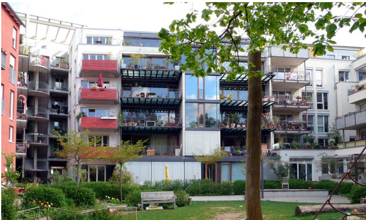
Hofsituation im Französischen Viertel in Tübingen: Der Hof wird gemeinsam von allen angrenzenden Baugemeinschaftshäusern geplant, es besteht ein Zwang zur Kooperation hinsichtlich Aufteilung, Planung und Kosten. Foto: RT
