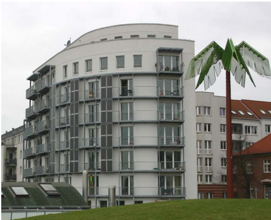
Baugemeinschaft Parkhaus e.V. am Pinnasberg in Hamburg/St. Pauli, Auftraggeber St. Pauli Hafensträßengenossenschaft e.G., fertiggestellt 2003 von Plan-R- Architekturbüro Joachim Reinig, Baubetreuer Stattbau Hamburg. Es handelt sich um Deutschlands erstes Passivhaus mit acht Vollgeschoßen. Foto: Plan-R- Architekturbüro
