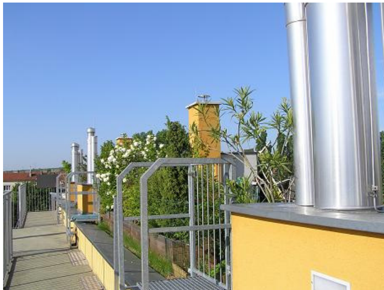
Private Dachgärten in der Simmeringer Hauptstraße 192a.
