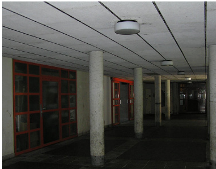
Bild: Säulendurchgang am Schöpfwerk.
