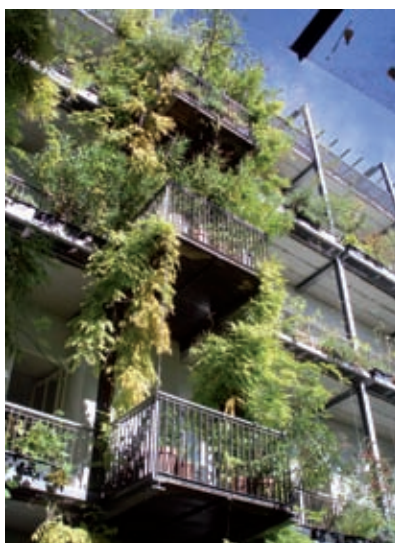
Vorgestellte Balkonstruktur, Innenhof Foto: Maja Lorbek
