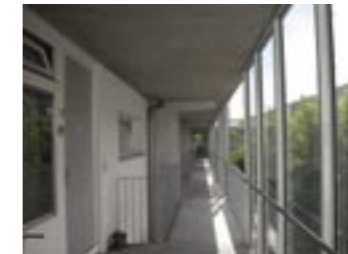
Blick entlang des Laubgangs
