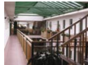
Ein Laubengang verbindet die Treppenhäuser im 2.OG, so dass fast alle Wohnungen mit dem Aufzug erreichbar sind
