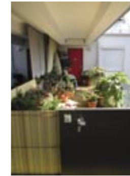
Die privaten Terrassen sind vom Laubengang aus einsehbar
