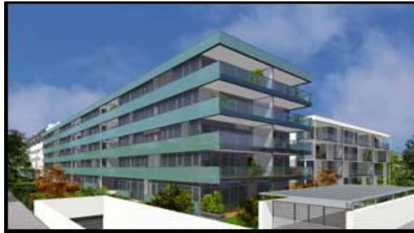
Projekt noch in Bau / Simulation
