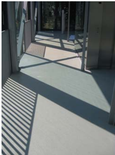
Abbildung 71: Unterschiedliche der Lichttransmission durch Verglasung, sichtbar gemacht durch unterschiedliche Leuchtdichten auf einer besonnenen Bodenfläche
