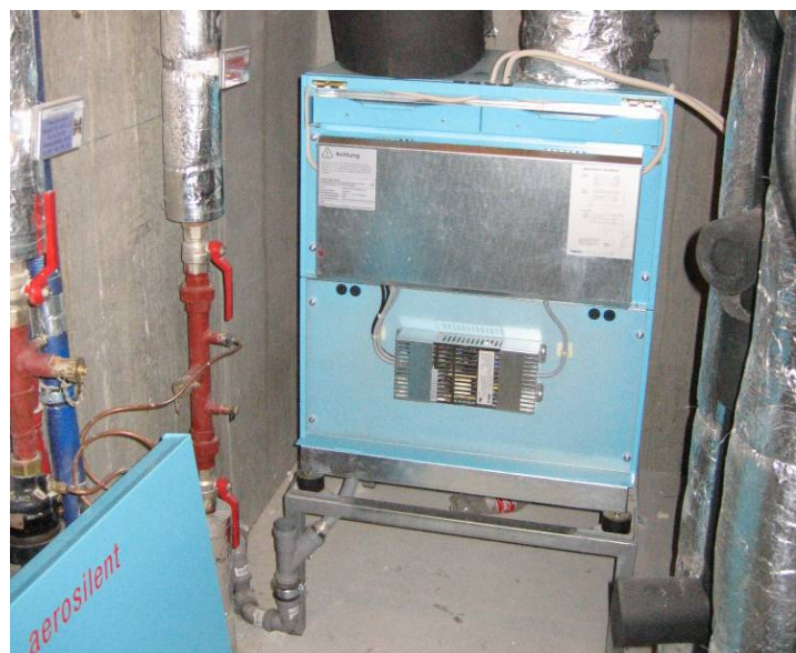
Abbildung 9: Dezentrales Lüftungsgerät für 2 Wohneinheiten mit je 2 Zimmern. Vordere Abdeckung entfernt. Drexel und Weiss Aerosilent Standard. Foto: R.Smutny
