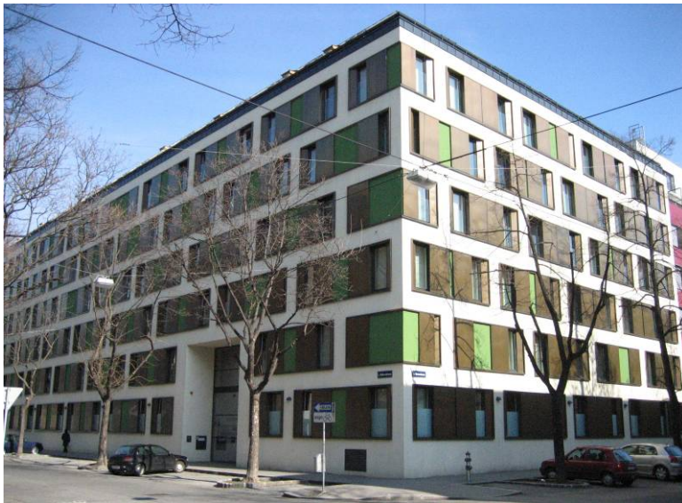
Abbildung 2: Studentenheim Molkereistraße, 1020-Wien, Molkereistraße 1. Foto: R.Smutny
