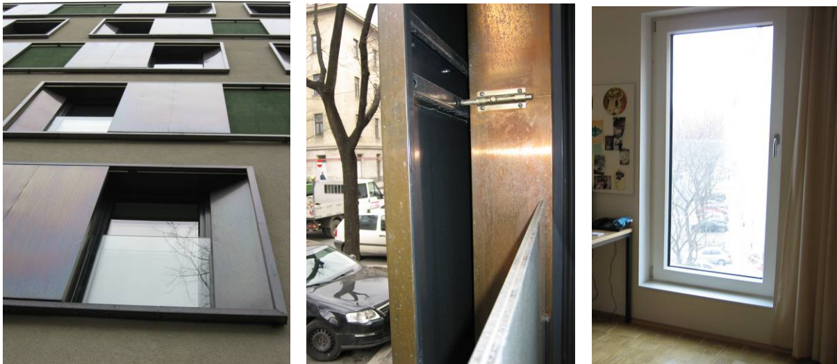
Abbildung 3: Außenfenster mit manueller Verschattungsmöglichkeit. Fotos: R.Smutny
