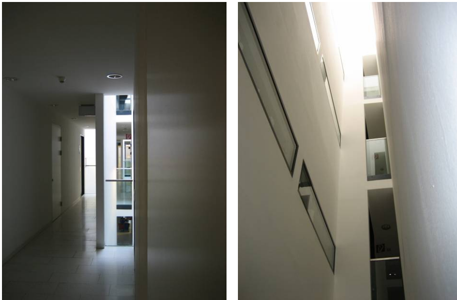
Abbildung 4: Zentraler Mittelgang und simulationsoptimierte Lichtschächte. Fotos: R.Smutny
