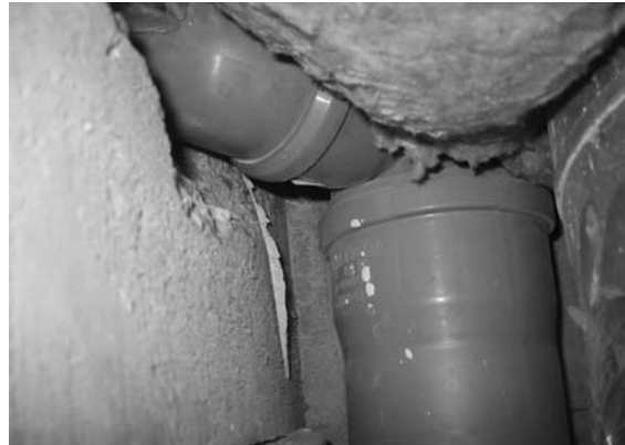
Abb. 1: Durchtrittsweg von Luftschadstoffen über Abflussrohr im Installationsschacht
