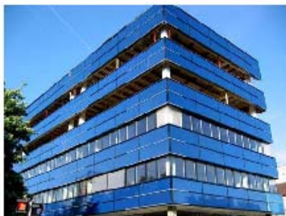
Abbildung 8: Sanierung eines Bürogebäudes in Linz mit hochvorgefertigten Holzelementen
