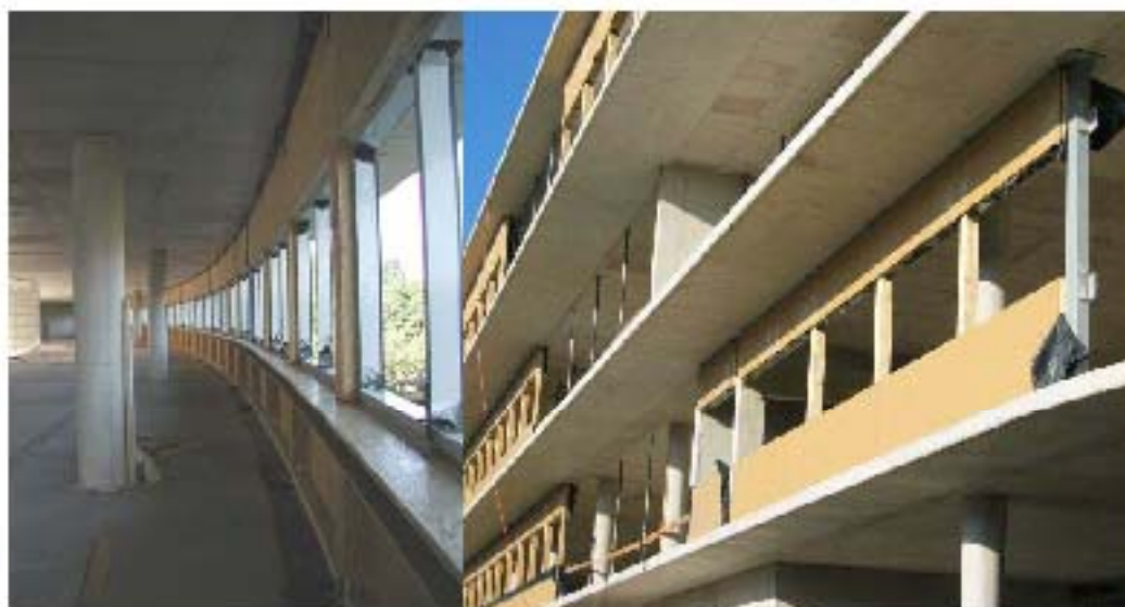
Abbildung 5: Anschluss der Holzelemente an die mineralische Struktur
