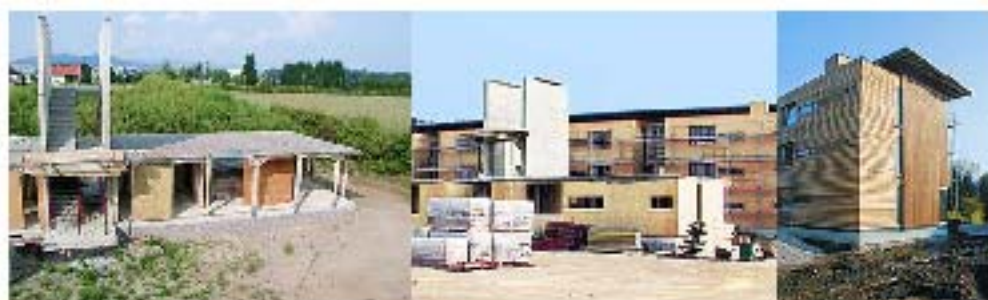
Abbildung 3: Baufortschritt Wohnanlage Harbacher Straße, Klagenfurt
