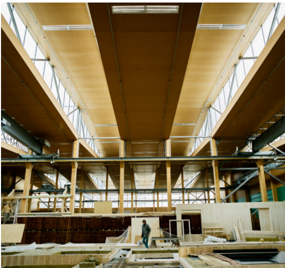
Elementfertigungshalle Obermayr, Foto: Lukas Schaller
