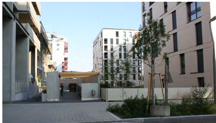
65: Nordbahnhof 2014 , Gebiet 1. Bauphase, Versperrter Durchgang zum Rudolf-Bednar-Park
