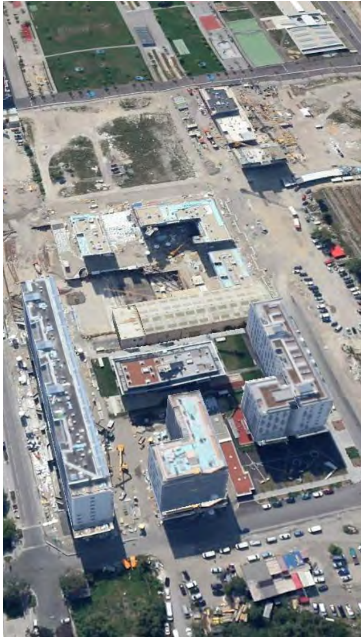
8: Realisierungsphase Nordbahnhof (1. Bauphase)
