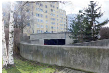
Das Parkdeck an der Nordseite der Wohnbebauung
