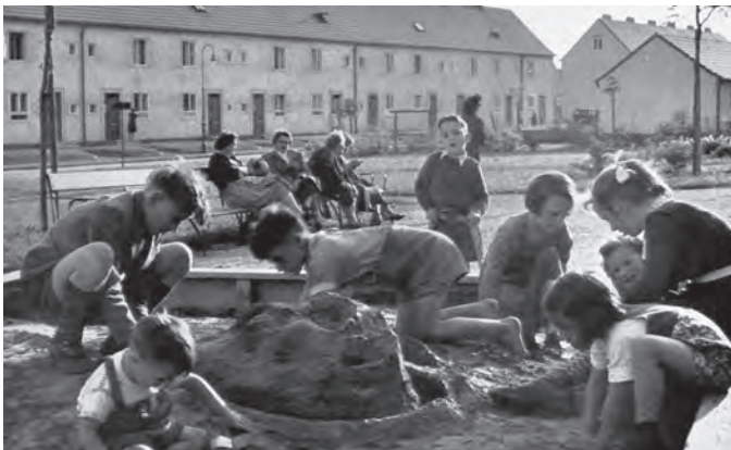
Spielplatz in der Per-Albin-Hansson-Siedlung in Wien, errichtet 1947–1955 Quelle: Stadtbauamt der Stadt Wien (Hg.): Der Soziale Wohnungsbau der Stadt Wien, Der Aufbau, Heft 32, Wien 1956
