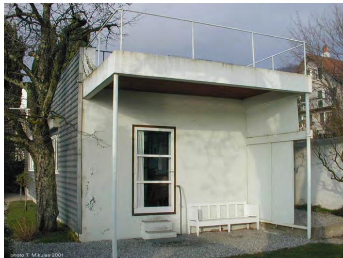
Tür vom Gästezimmer auf die überdachte Terrasse. Über der Terrassenabdeckung ist ein Stückchen vom Oberlicht zu sehen.
