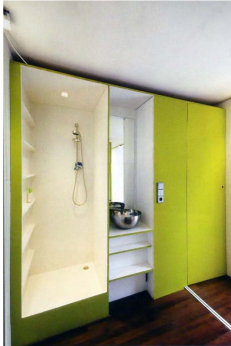
Dusche, Handwaschbecken, WC-Türe
