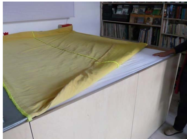
Die Matratze ist so eingebaut, dass noch Holzplatten als Abschluss des Podests darüber gelegt werden können.
