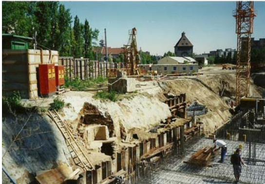
Bild 5.32: Bergung des Urselbrunnens beim Bau des PORR Hochhauses
