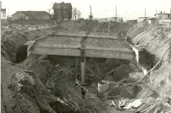
Bild 5.42: Autobahnbau am Verteilerkreis Favoriten 1970-71
