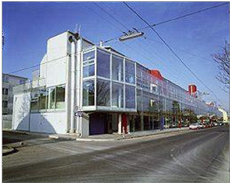
Abbildung 3: Wohnhaus Brünnerstraße 26-32, 1230 Wien
