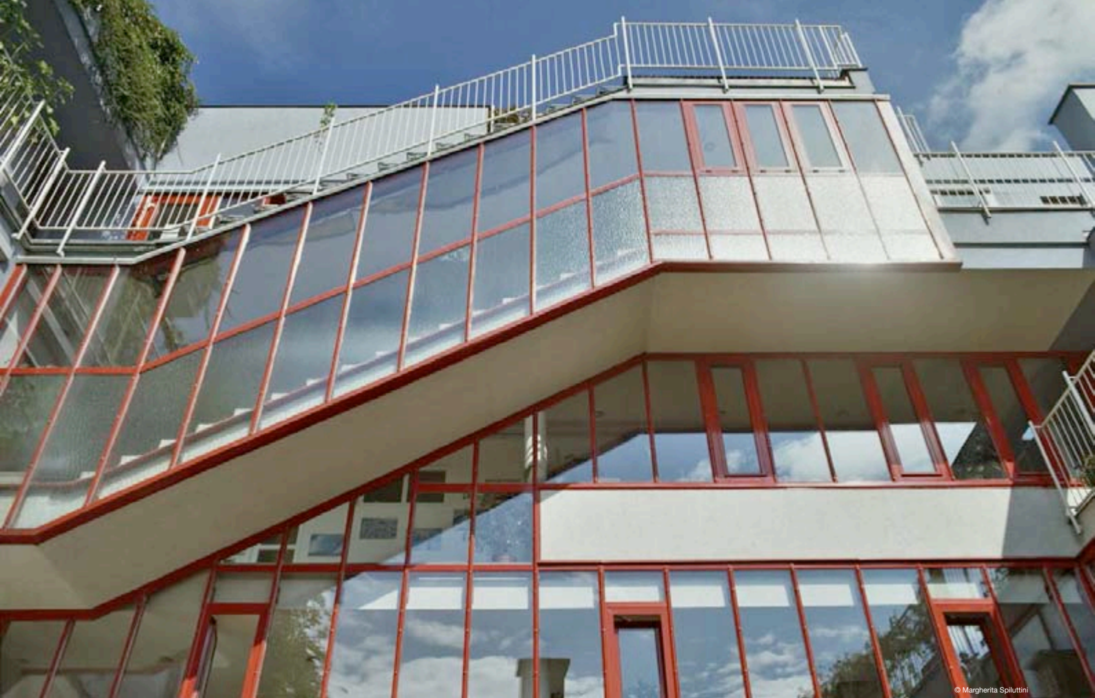
B.R.O.T. Hernalts (1986–90); Geblergasse 78, 1170 Wien. Architektur: Ottokar Uhl (Mitarbeit Franz Kuzmich, Martin Wurnig)
