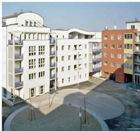
Modellprojekt „Frauen-Werk-Stadt“ (1995-1997), Donauefelderstraße 95-97, 1210 Wien. Architektur: Liselotte Peretti, Gisela Podreka, Elsa Prochazka, Franziska Ullmann
