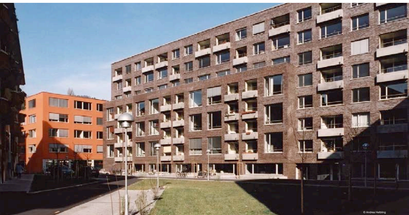
Kraftwerk1 (1993–2001); Hardturmstrasse, Zürich. Architektur: Stücheli Architekten mit Bünzli Courvoisier
