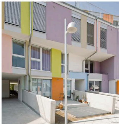
Wohnhof Orasteig (2005–2009). Architektur: PPAG Architects
