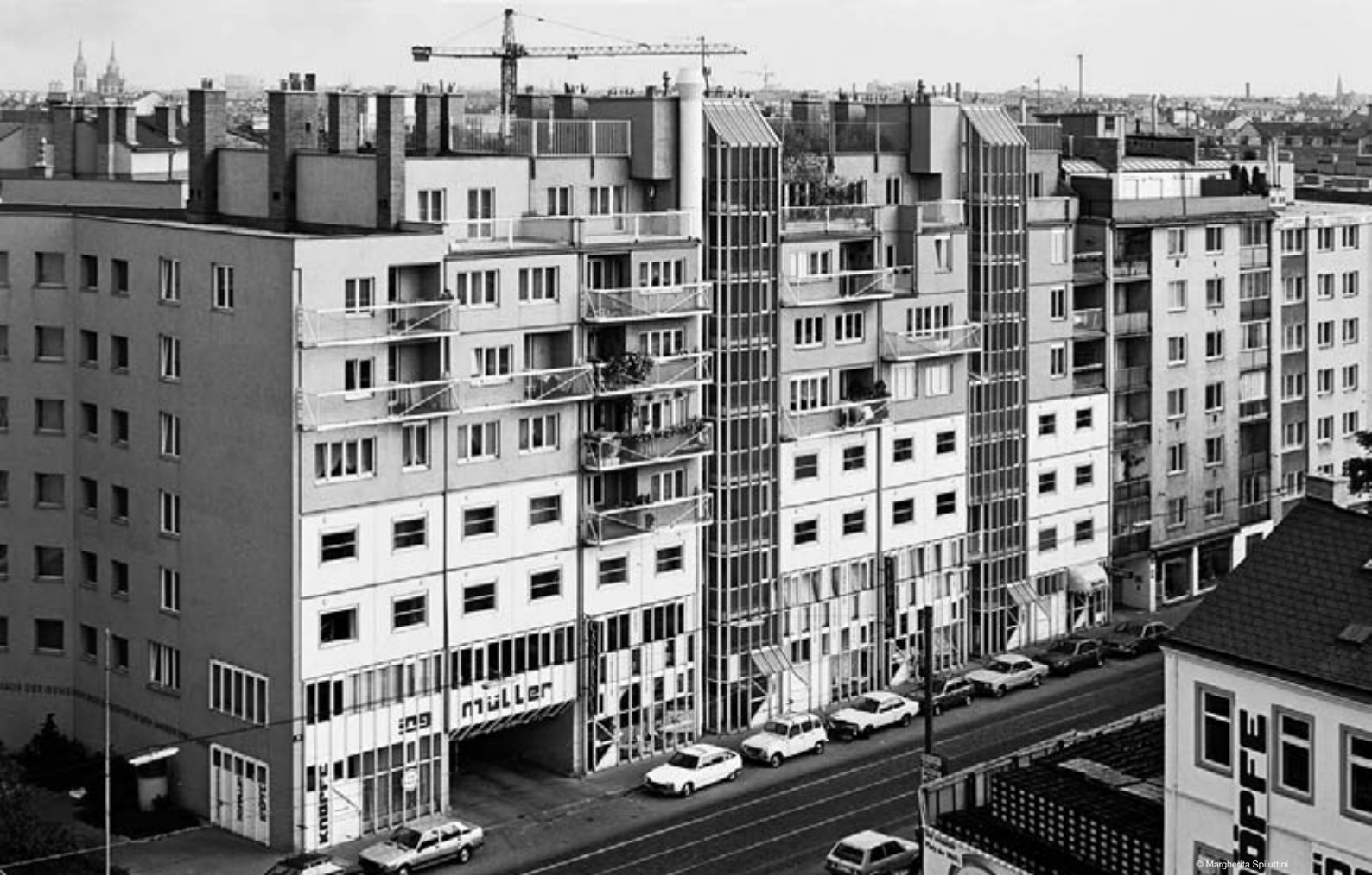
Gemeindebau Feßtgasse 12-14 (1973-1980), 1160 Wien. Architektur: Ottokar Uhl
