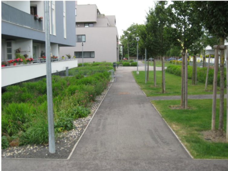
Abbildung 14: Umsetzungsbeispiel für einen Kies- und Pflanzpuffer als Zwischenzone und Abstandshalter zur Straße (BAG 4)
