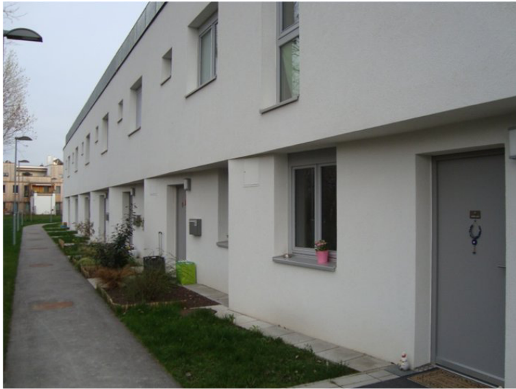
Abbildung 36: Umsetzungsbeispiel für die Gestaltung der Gebäuderückseite – Rücksprünge schaffen Abwechslung und eine private Schwelle (BAG 1)
