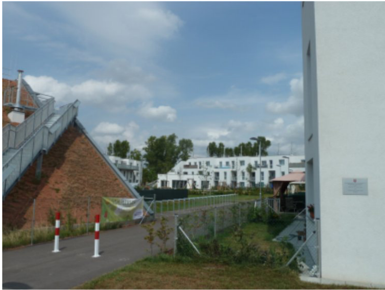
Abbildung 13: Umsetzungsbeispiel für symbolische Barrieren zur Gestaltung des Übergangs vom öffentlichen zum teilöffentlichen Bereich (BAG 1)
