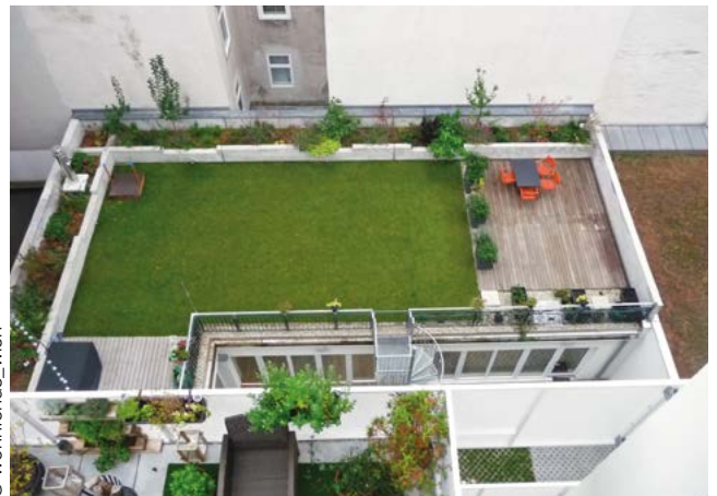
Innenhof nach Sanierung
