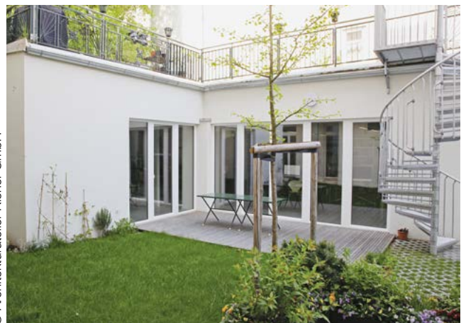
Innenhof nach Sanierung
