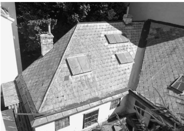
Innenhof vor Sanierung
