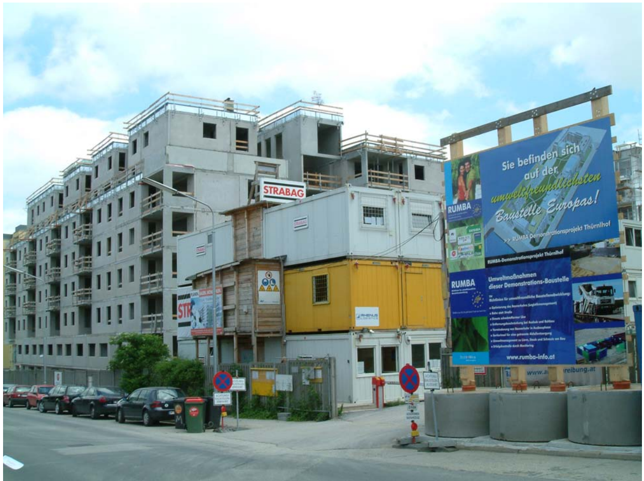
Baustelleneinfahrt Thürnhof Ost
