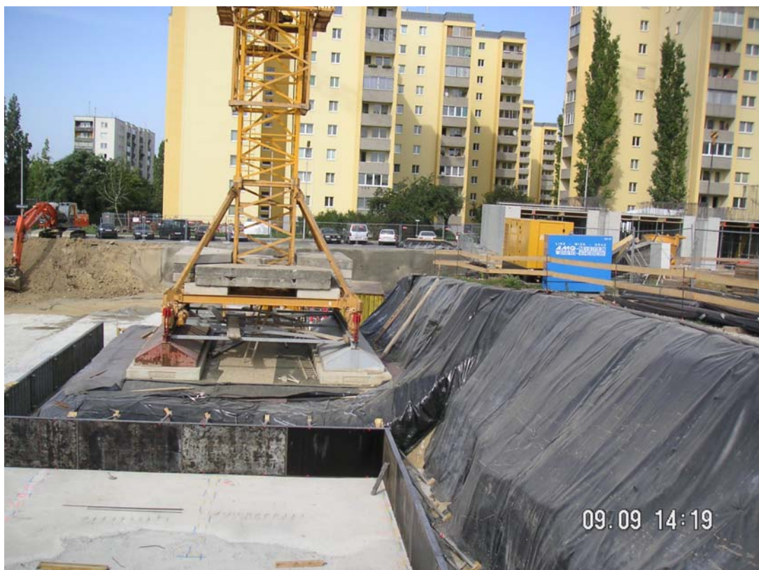
Baugrubensicherung am Thürlhof Ost
