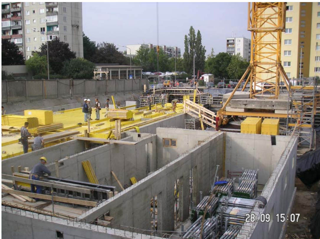
Platzmangel während des Rohbaus
