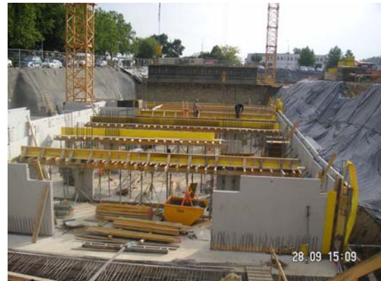
Abb. 13 u. 14 Befestigte und abgedeckte Baugrube mit Feinsand
