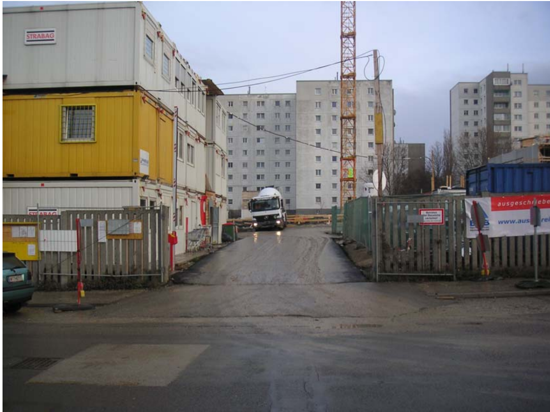
Baustelleneinfahrt mit asphaltierter Baustraße
