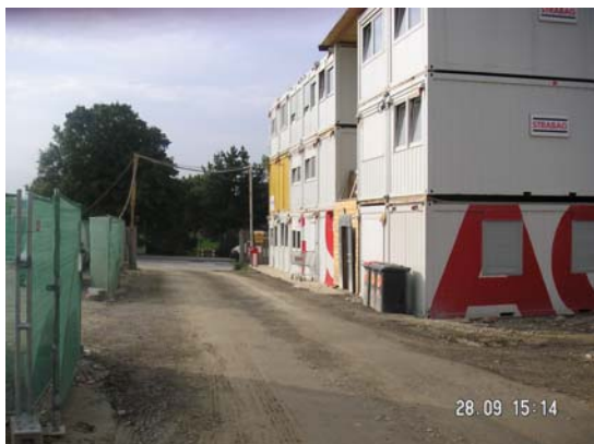
Abb. 15 u. 16 Granulatbefestigte Baustraße zwischen Sortierinsel und Containerdorf mit Bauschranke (später asphaltiert); Dauerparker neben Baustelleneinfahrt
