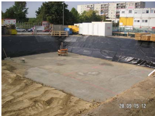
Abb. 13 u. 14 Befestigte und abgedeckte Baugrube mit Feinsand
