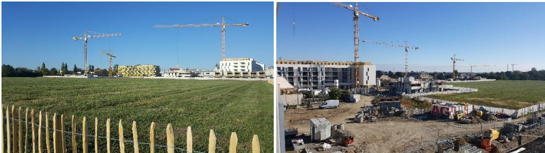
Abbildung 7: Bauphase „Wohnen am Marchfeldkanal“ im Herbst 2018
