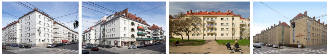
Abbildung 3: Gemeindebauten in der unmittelbaren Umgebung, von links nach rechts: Hueber-Hof, Quellenstraße 24a, Erlachgasse 53, Emil Fucik-Hof (Fotos: Wiener Wohnen)
