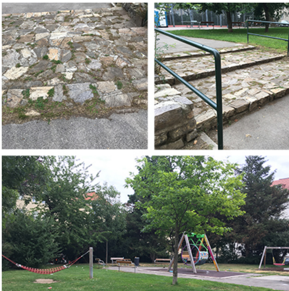
Abbildung 15: Ansichten aus dem Mundypark, Fotos oben zeigen die Stufen aus zwei Blickrichtungen, unten der Spielbereich (Fotos: Höfner und Team Spitaler)
