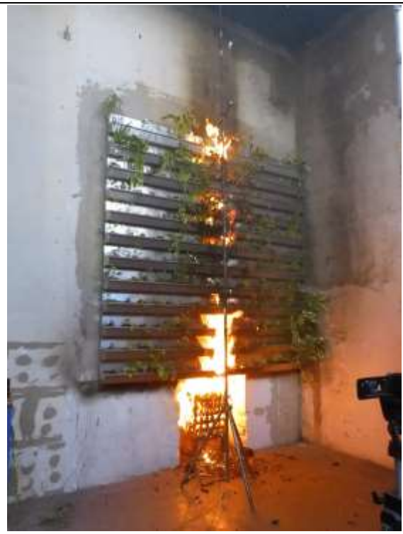
Abbildung 4-36: Fassadenbegrünung während des Versuches (Versuchsdauer 14 Minuten)
