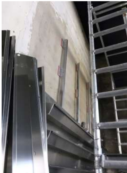
Abbildung 4-14: Montage der Unterkonstruktion am Prüfstand sowie der Tröge an der Unterkonstruktion
