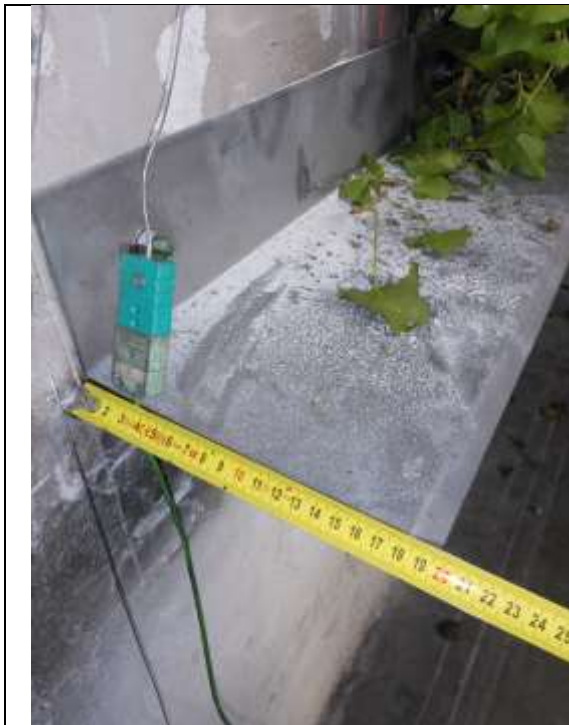
Abbildung 4-3: Dimension der Brandabschottung, 20 cm Auskragung
