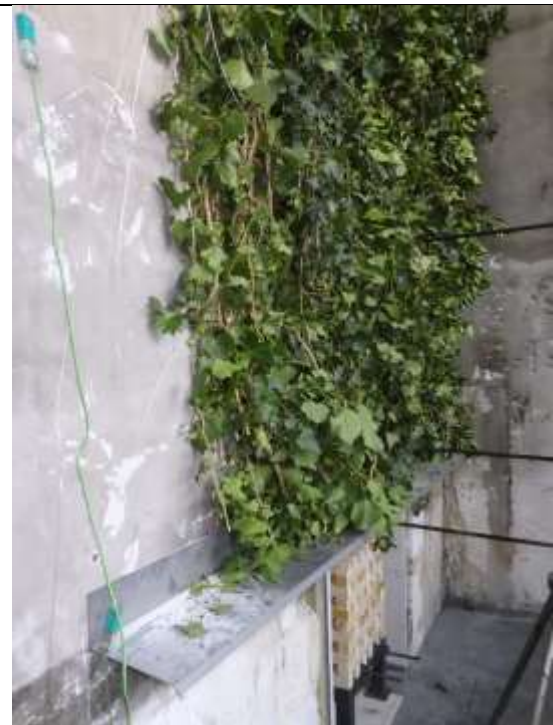
Abbildung 4-4: Gesamtansicht der Prüfanordnung vor dem Versuch
