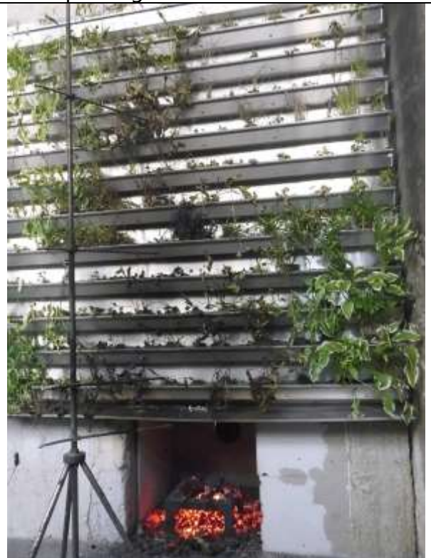
Abbildung 4-30: Fassadenbegrünung nach der Prüfung
