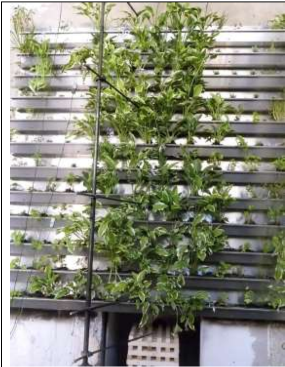
Abbildung 4-35: Fassadenbegrünung unmittelbar beim Start des Versuches
