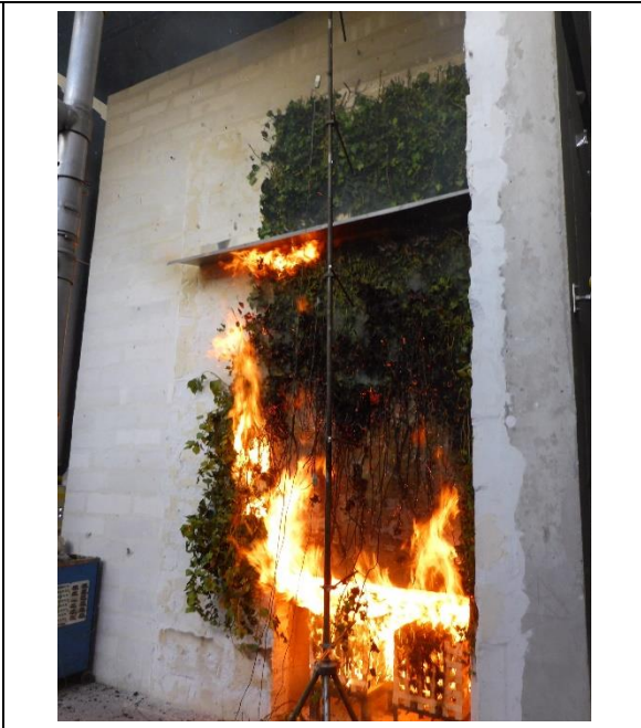
Abbildung 4-8: Flammen erreichen neuerlich die Abschottung (5 Minuten 20 Sekunden)
