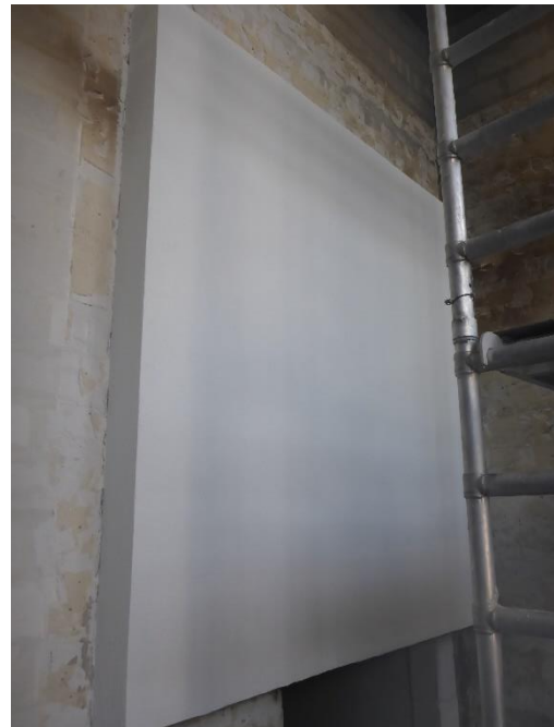
Abbildung 4-14: armieren und spachteln des WDVS
