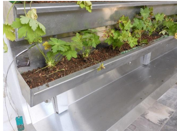
Abbildung 4-16: Befüllen der Pflanztröge, darunter Brandabschottung und Unterkonstruktionsschienen
