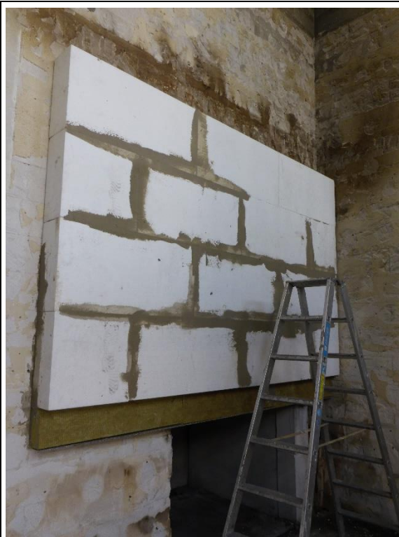
Abbildung 4-11: Verkleben und Verdübeln der EPS-Platten und des Brandschutzriegels am Fassadenprüfstand
